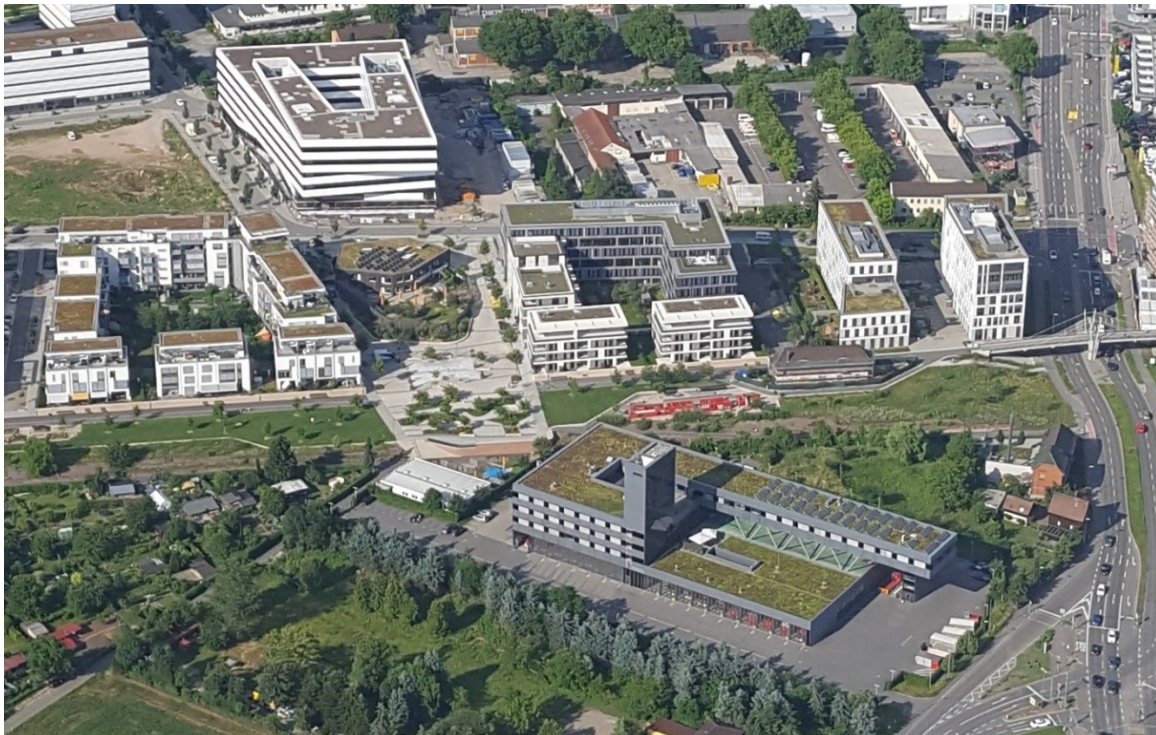
Abbildung 22: Luftaufnahme der Schwetzingter Terrasse in der Bahnstadt, im Vordergrund die Berufsfeuerwache der Stadt Heidelberg (Eigene Aufnahme am 03.06.2018).
