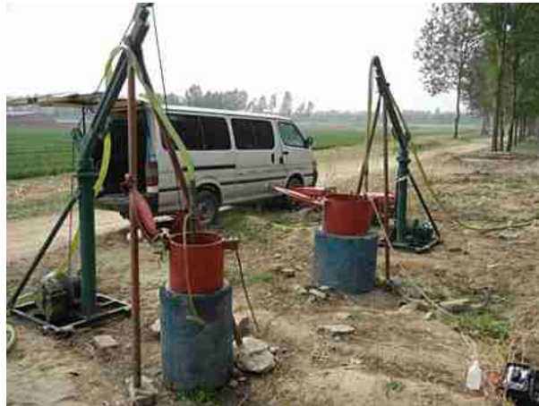
(b) ... mit installierten Pumpen
