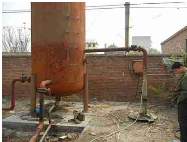
(d) Produktionsbrunnen für Trinkwasserversorgung mit Speichertank
